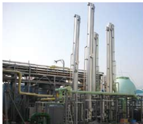
バイオ天然ガス精製設備
