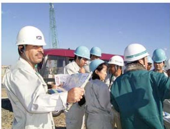
北九州市での下水道工事現場研修の様子
