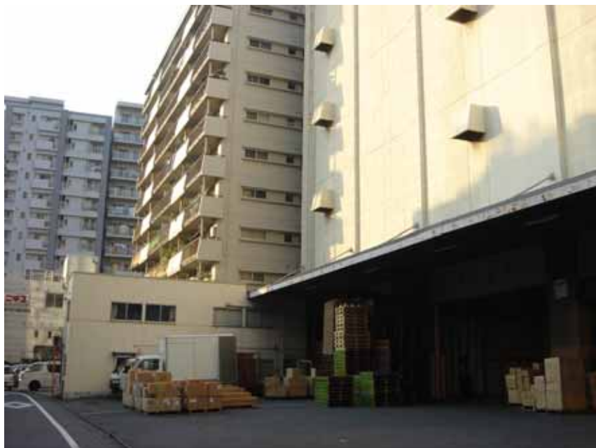
マンションと普通倉庫が隣接
