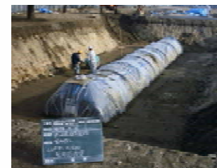
耐震性貯水槽
