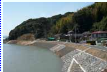
堤防の整備(高知県国分川)
