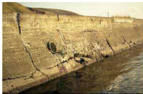
堤防の表法被覆工が損傷
