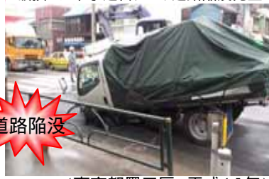
破損した下水道管により道路陥没発生
