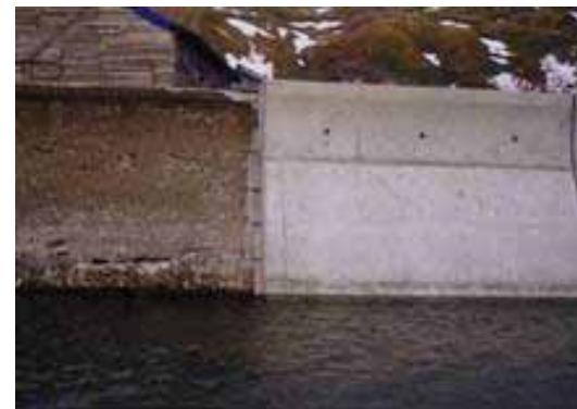
老朽化対策による改良例
