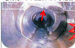
老朽化により破損した下水道管
