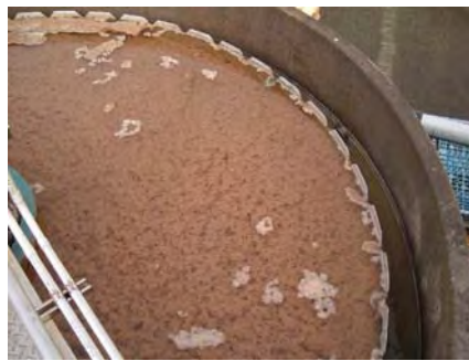
キャリーオーバー気味の沈殿池
