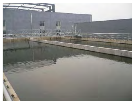
凝集沈殿槽
