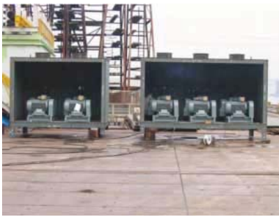
写真6 設置したブロー5台(ブロー：大きな送風機のこと)
