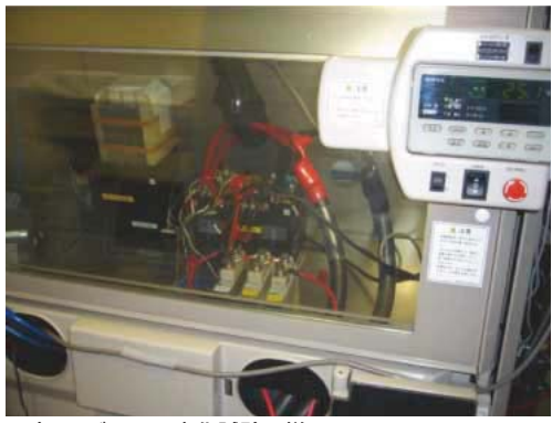
写真4 バッテリー劣化試験の様子
