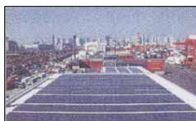
ゲート屋根へ太陽光パネルを設置
