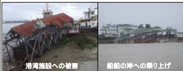
ヤンゴン港における高潮災害の緊急現地調査報告(速報) ( (独)港湾空港技術研究所)より
