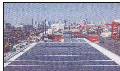
ゲート屋根へ太陽光パネルを設置
