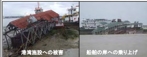
港湾施設への被害 船舶の岸への乗り上げ ヤンゴン港における高潮災害の緊急現地調査報告(速報) (独)港湾空港技術研究所より
