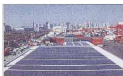
ゲート屋根へ太陽光パネルを設置
