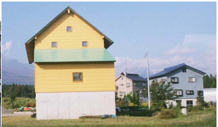
写真-2 2004年新潟中越地震の被災地内の雪国仕様建物
