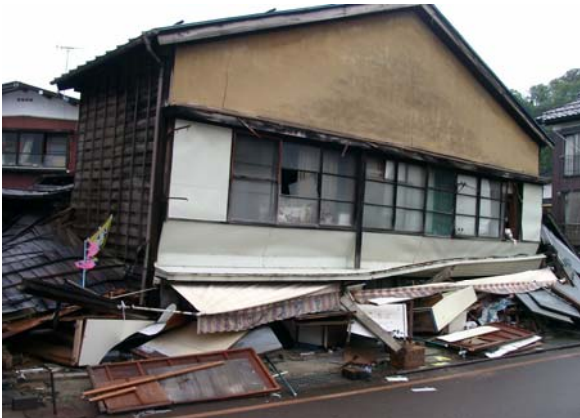
写真-1 2004年新潟中越地震の被害建物
