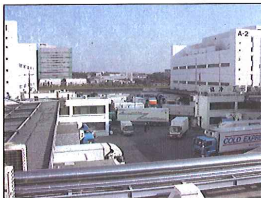
写真: 冷蔵倉庫前の狭小なエプロン
