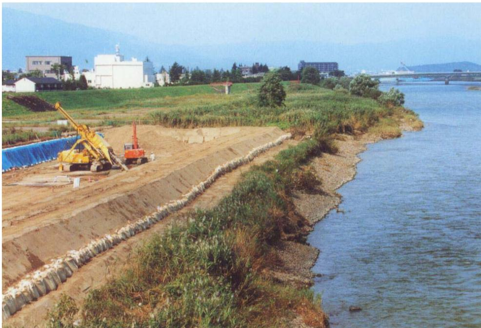
写真一 1 地中控え護岸の施工状況
