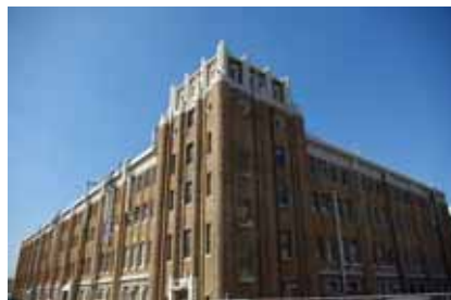
旧神戸生糸検査所
