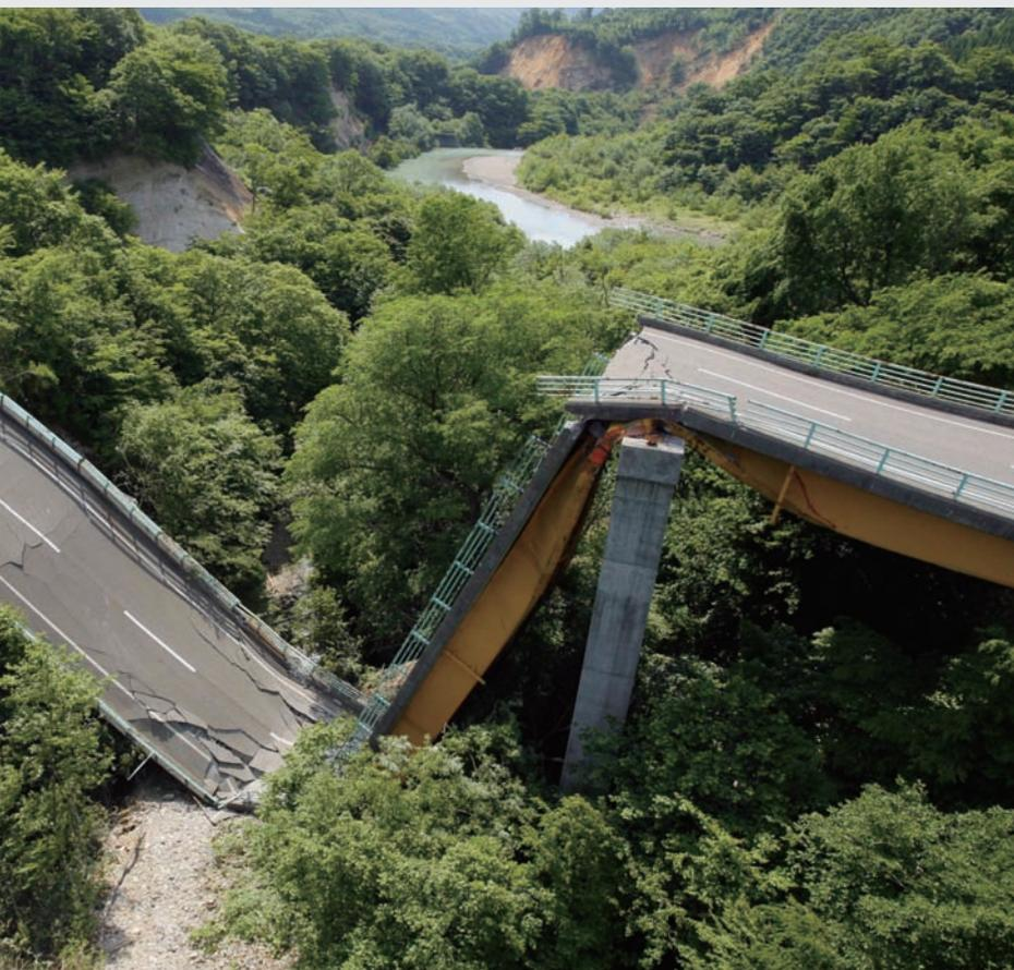
▲地震により崩落した国道342号祭時大橋(岩手県一関市)
