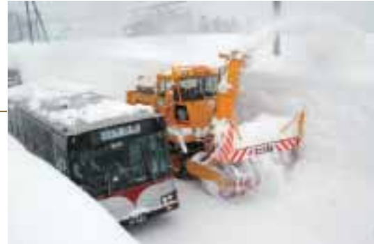
▲北陸地方整備局による新潟県への除雪車支援（新潟県津南町県道秋成下船渡線） 〔写真提供／北陸地方整備局〕
