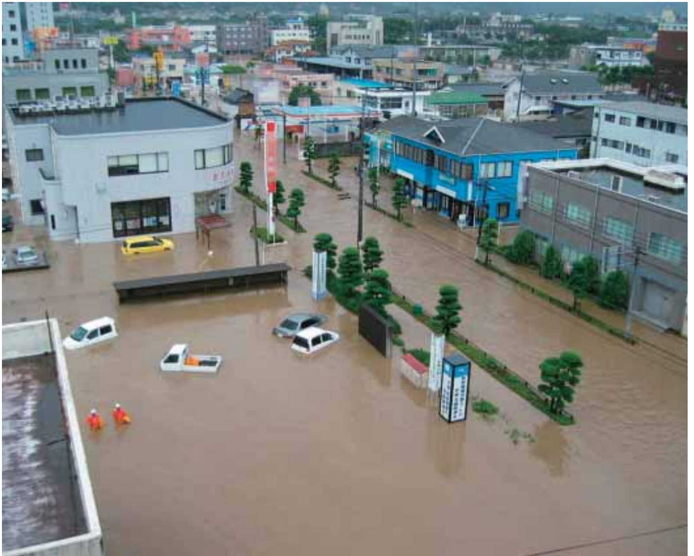
▲浸水した出水市役所前（国道447号）〔写真提供／鹿児島県出水市〕
