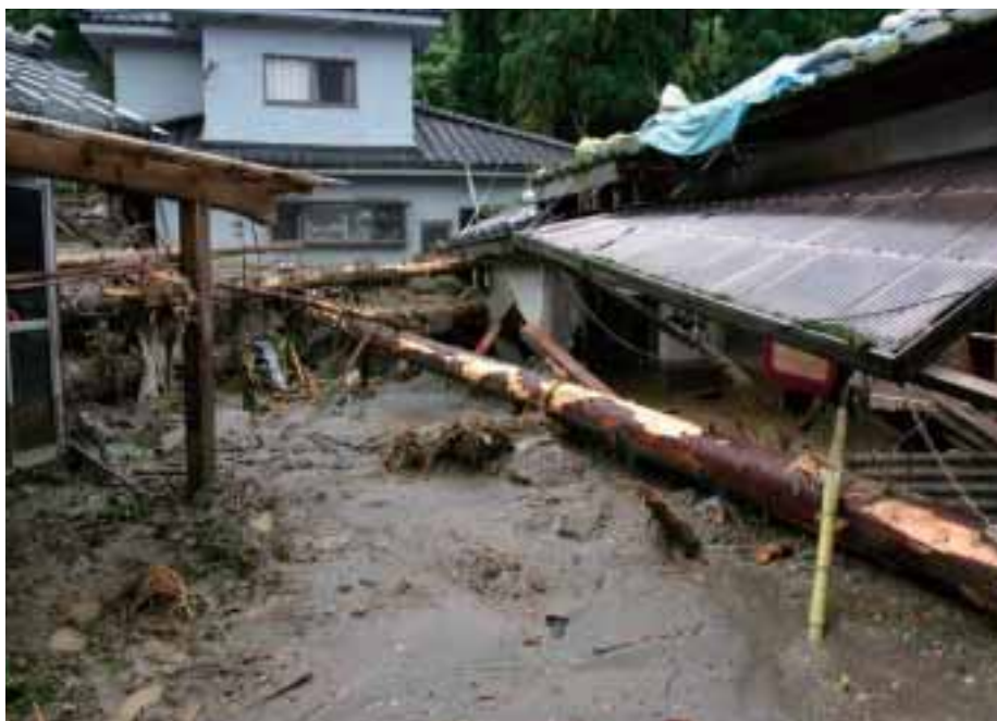
▲土石流により埋まった家屋（鹿児島県垂水市上市木地区）〔写真提供／鹿児島県垂水市〕
