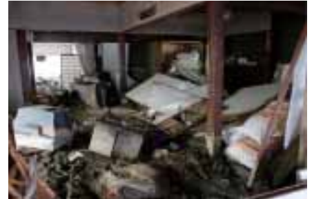
▲土石流が襲った家屋内（鹿児島県垂水市上市木地区）〔写真提供／鹿児島県垂水市〕
