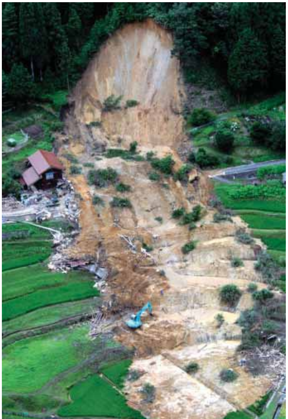
▲大雨による土砂崩れで民家が押し流された現場（島根県美郷町久保地内）〔写真提供／共同通信社〕
