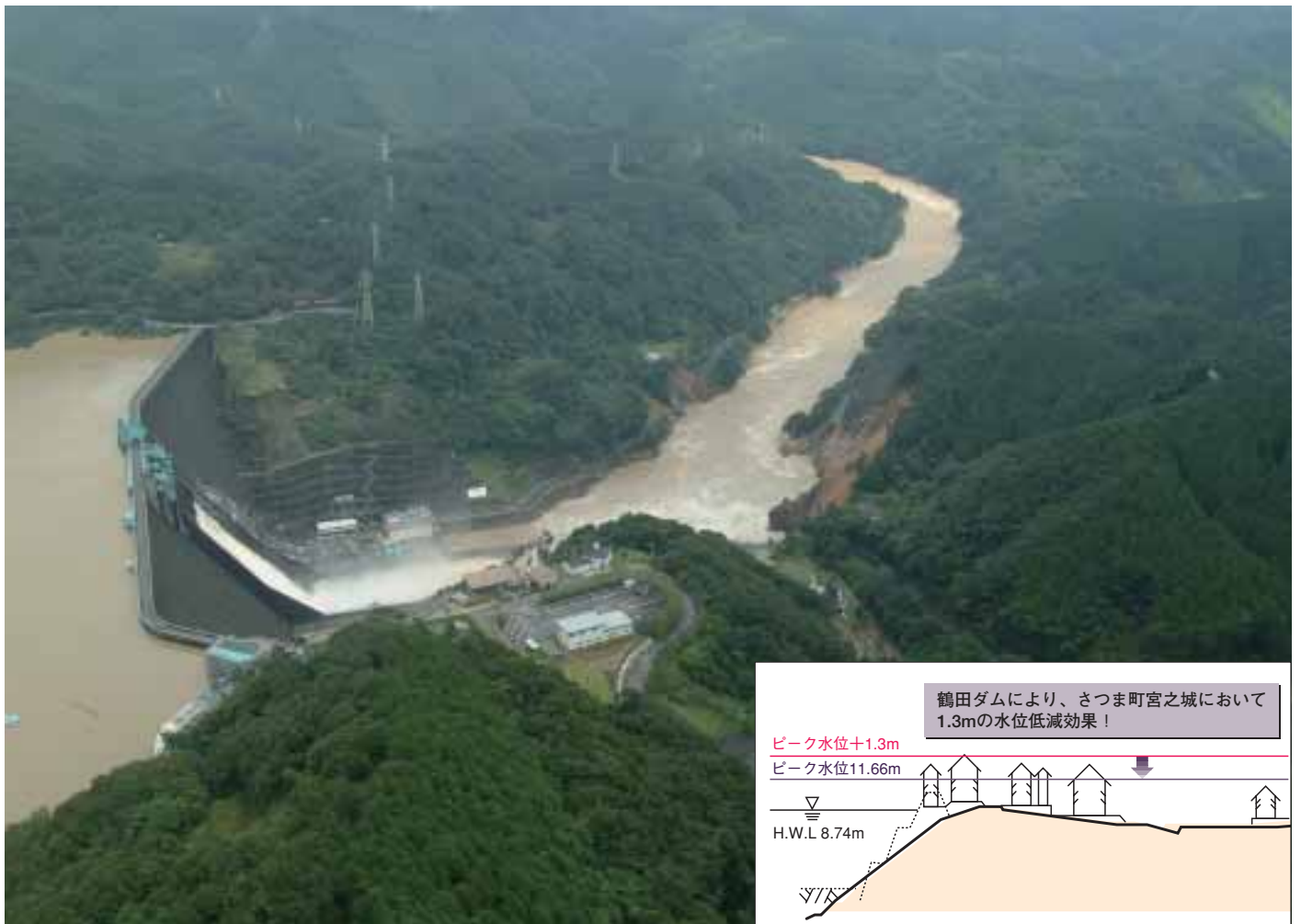
▲洪水時に大量の水を溜め込んだ鶴田ダム (写真提供/川内川河川事務所)
