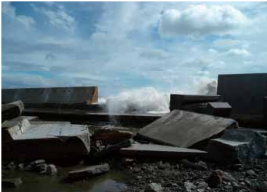
◀風浪によるパラベットの被害を受けた久慈港湾（岩手県久慈市半崎） 〔写真提供／岩手県県土整備部〕
