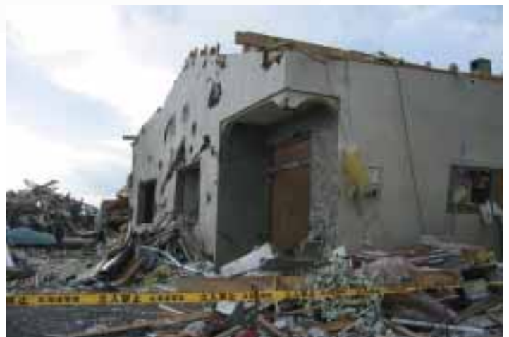
▶竜巻により大破した建物。壁面には木片などの飛散物が突き刺さって穴が多数あき被害になっている。(北海道佐呂間町若桜地区にて2006年11月9日撮影) 〔写真提供／高知大学佐々助教授〕
