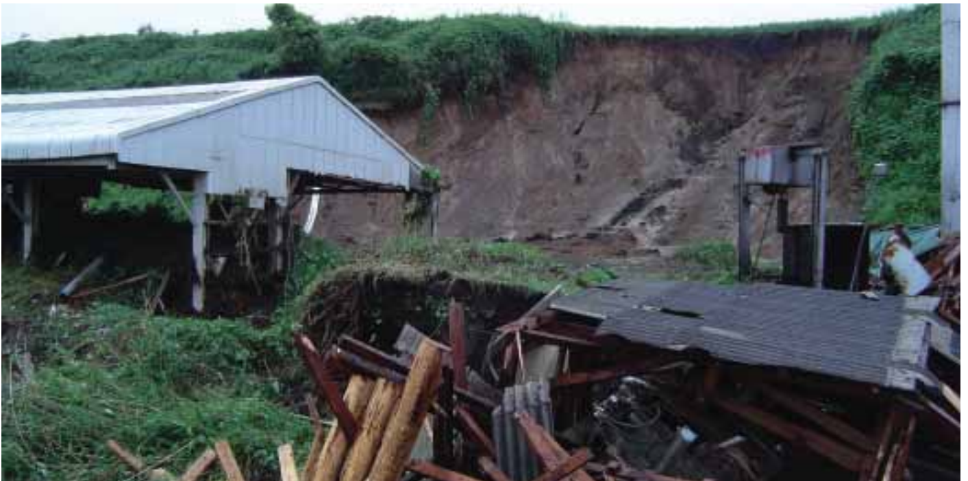
▼がけ崩れによる犠牲者が出た木材加工所（熊本県山都町）〔写真提供／熊本県土木部〕
