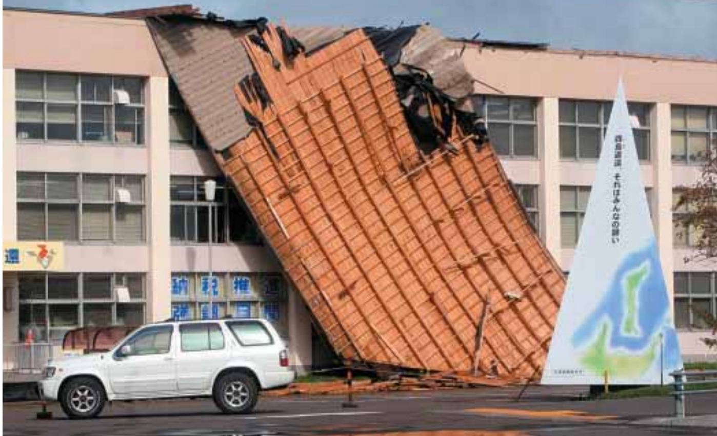
▲強風ではがれた根室支庁の屋根（北海道根室市）〔写真提供／読売新聞社〕
