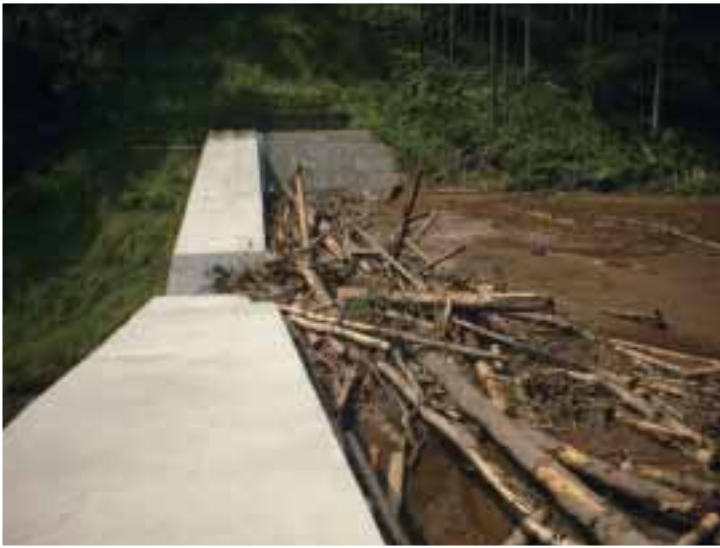
▲土砂を捕捉して下流の道路・家屋を守ったヒライシ沢砂防堰堤（長野県岡谷市間下地区） 〔写真提供／長野県土木部〕
