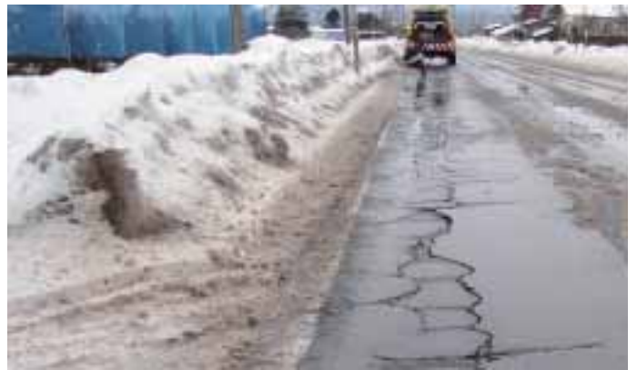
▲主要地方道紫波インター線の凍上災現場（岩手県紫波町平沢地区） 〔写真提供／岩手県県土整備部〕
