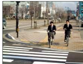
自歩道幅員の確保及び段差の解消
