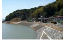
堤防の整備(高知県国分川)
