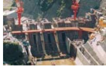
ダムの建設 (静岡県 長島ダム)
