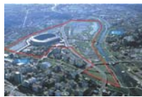
遊水池の整備 (神奈川県 鶴見川遊水池)
