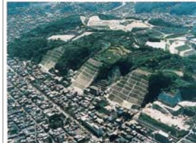
急傾斜地崩壊防止施設の整備 (鹿児島県 鹿児島市武)
