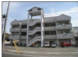
津波避難ビル(民間施設) 出典)和歌山県串本町
