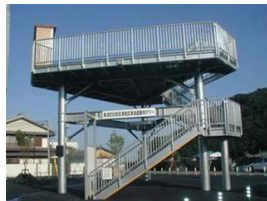
津波避難タワー 出典)高知県四万十市
