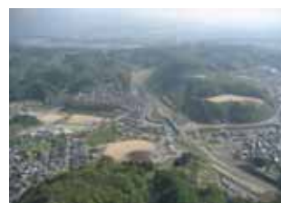
図6 金沢外環状道路東長江町付近(石川県)
