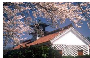
旧新潟税関庁舎 (「みなとびあ」(柳島町)にある旧新潟税関庁舎跡。)
