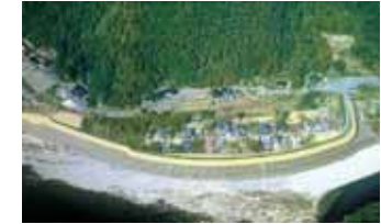
河川堤防の整備
