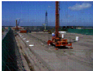
道央圏連絡道路(美原道路)
