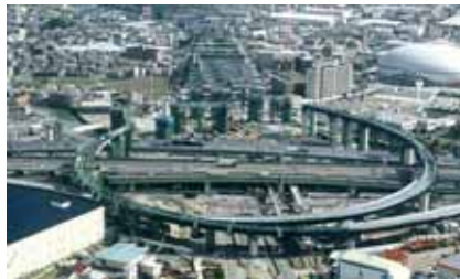
第二京阪道路(大阪北道路)
