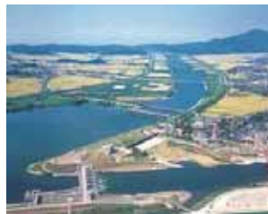
大河津可動堰改築
