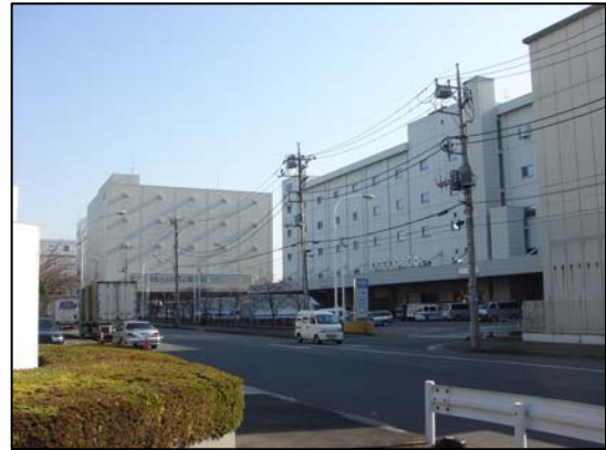
(左：TRC 内部、右；C 棟およびD 棟) (平成 20 年 12 月撮影)
