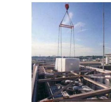
(屋上へのコージェネレーション機器の導入)
