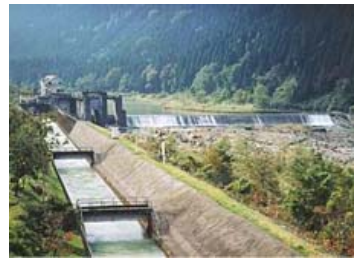
【出典】手取川七ヶ用水土地改良区HP
