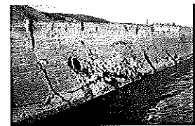
堤防の表法被覆工が損傷
