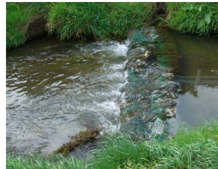
北須川への木炭設置状況
