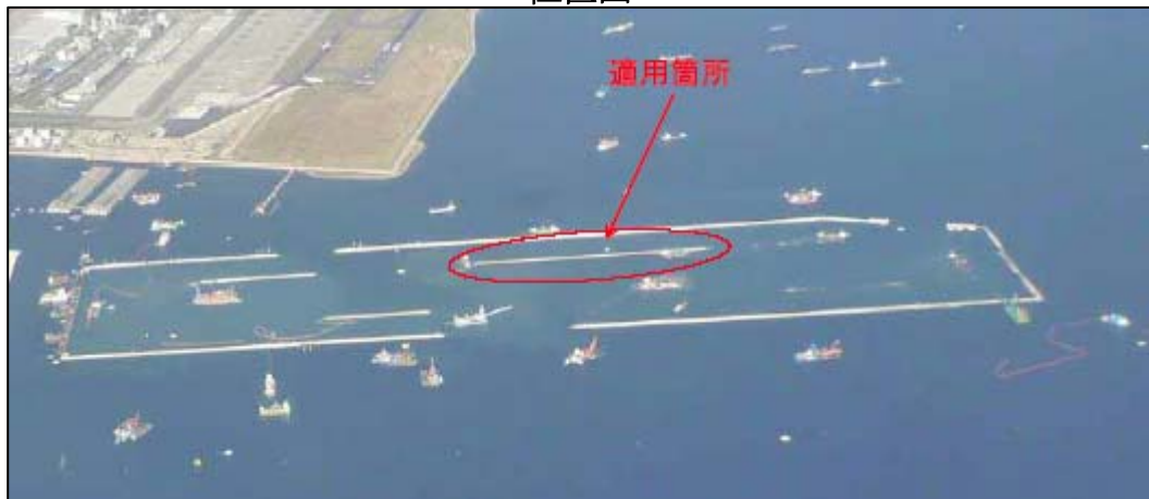
図-3.1.7.1 鉄鋼スラグ水和固化体製人工石材を中仕切り堤に適用
