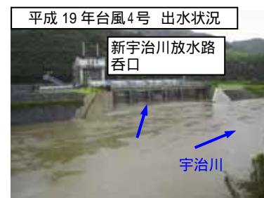
図 6 宇治川床上浸水対策特別緊急事業の整備(高知県いの町)
