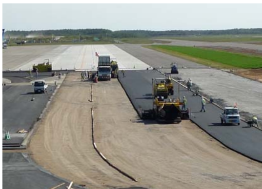
【誘導路舗装の改良】
