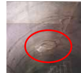
トンネル覆工コンクリートの剥落
