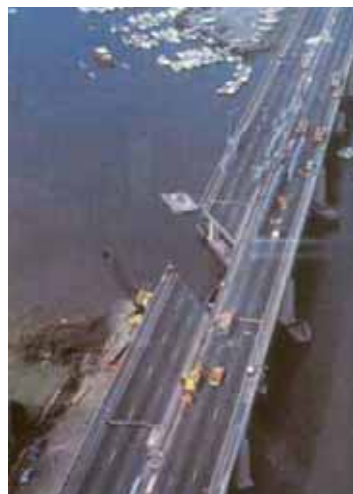
老朽化による橋梁の崩壊(アメリカ 1983年) (国土交通省道路局HP)
