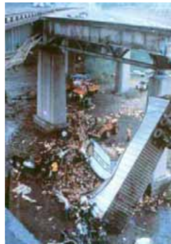
老朽化による橋梁の崩壊(アメリカ 1983年) (国土交通省道路局HP)
