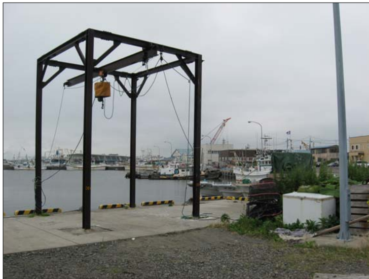
工事箇所現況施設配置状況
