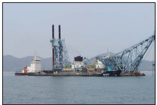
備讃瀬戸航路における浚渫工事の様子
