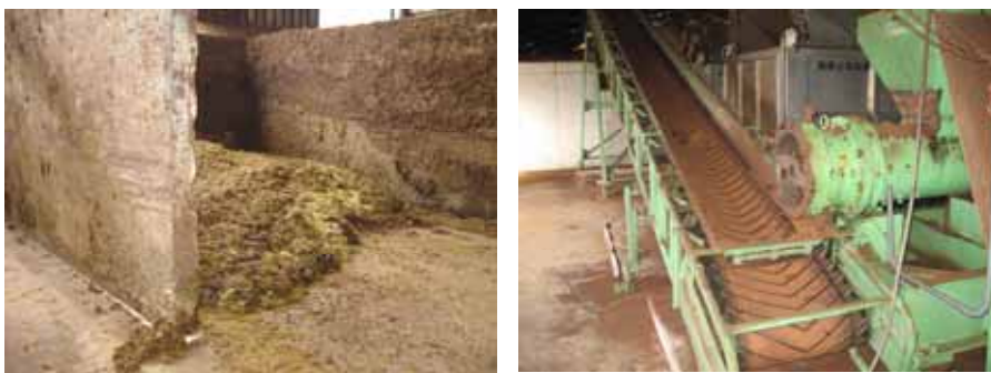
図 1-2-30 たい肥舎の内部
