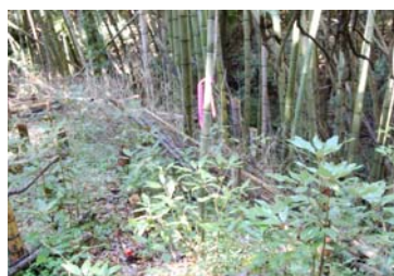
境界ポイントへの杭打ち
