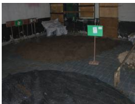
堆肥化センター内部
