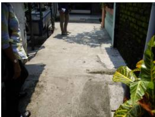
処理装置は、地下に埋め込まれている。
