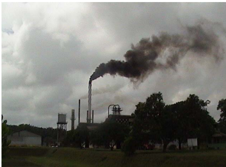
パームオイル工場からの排煙
