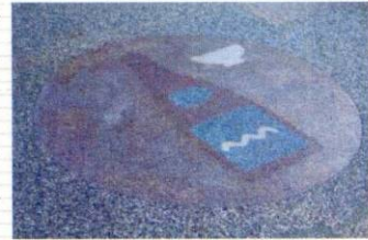
不良品ガラスのカレットを道路などの景観舗装に。水俣市の商店街などにも使われている。
