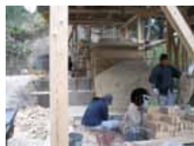
写真 建設中の登り窯
