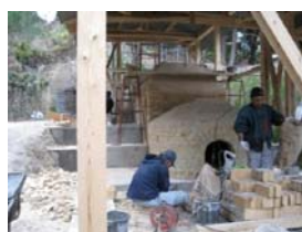
写真 建設中の登り窯
