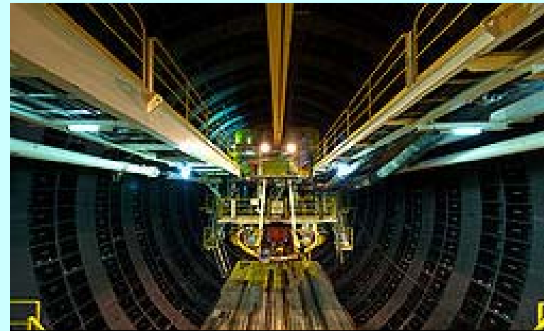
シールドマシン後部。2008年6月、建設中の大橋ジャンクショントンネル部のもの (Wikipediaより)
