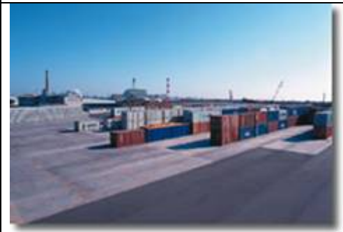
コンテナヤード
