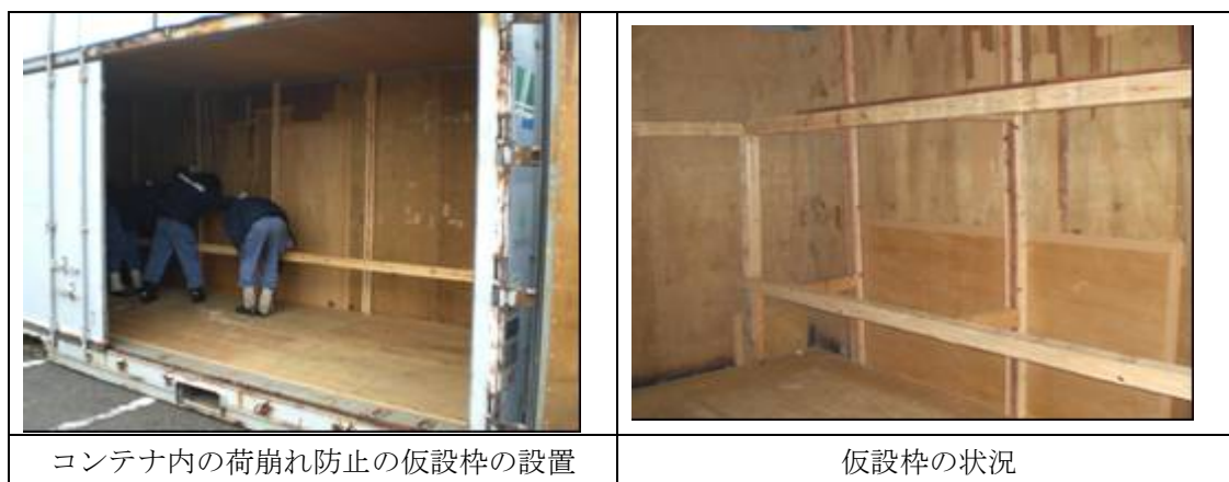
図2-10 実証実験で行ったコンテナへの仮設枠設置
