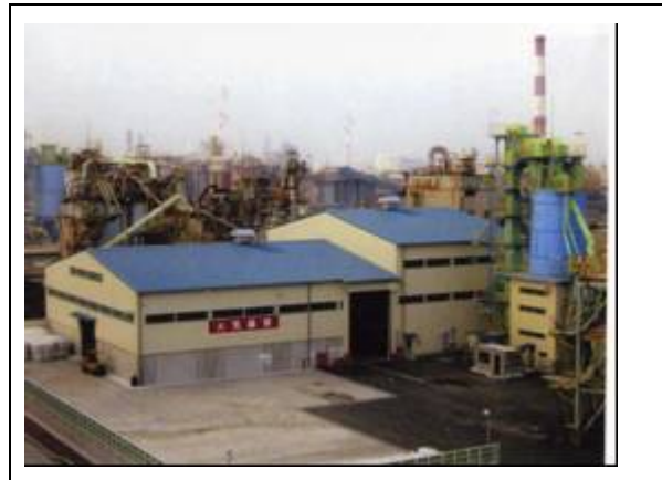
図 2-25 廃棄物の受入用建屋
