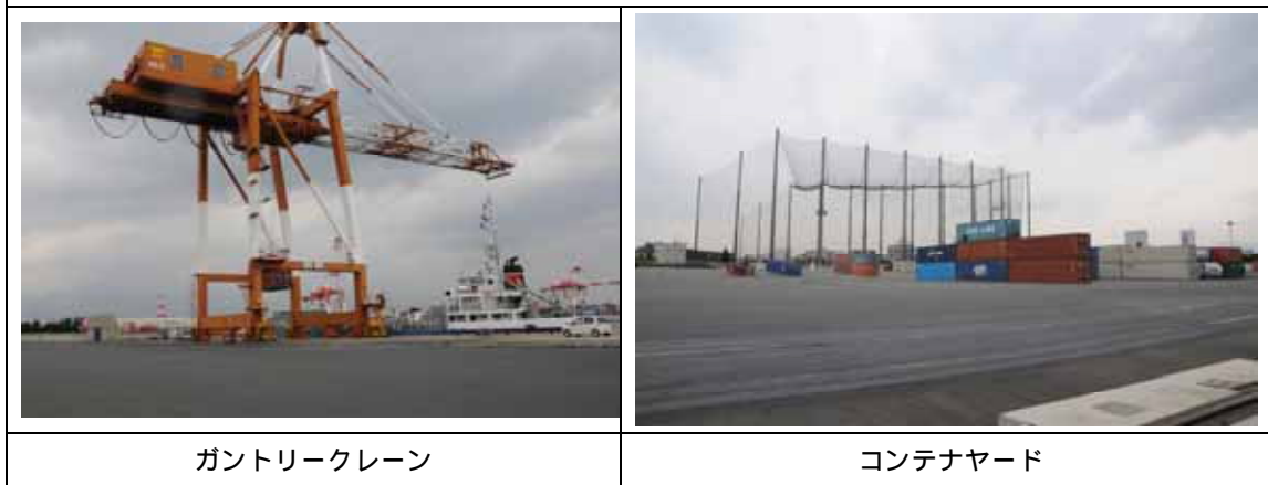
図 3 - 1 2 神戸港の使用施設
