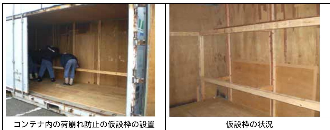
図3 - 10 実証実験で行ったコンテナへの仮設枠設置
