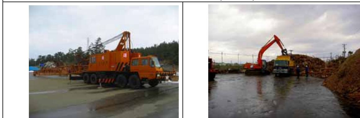
トラッククレーン
