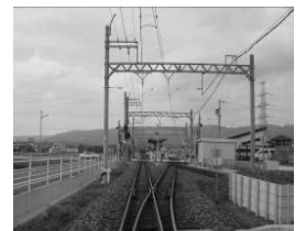
行き違い設備
