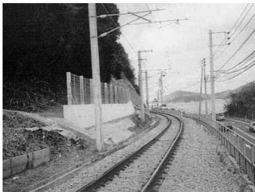
【落石防止擁壁の一例】
