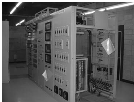
【変電所施設の一部】
