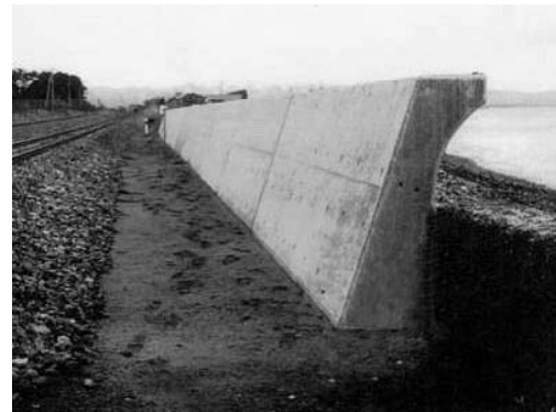
【護岸壁の一例】
