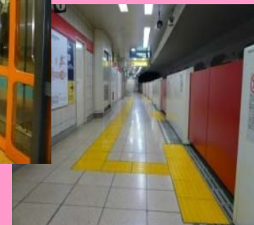
可動式ホーム柵 線状・点状ブロック
