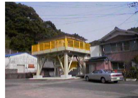
○避難タワーの設置
