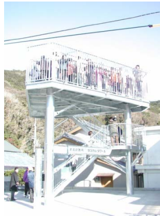
○避難タワーの設置
