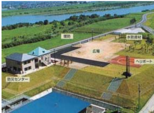
○防災ステーションの上屋整備
