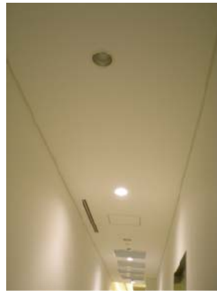
従業員通路照明の間引き
