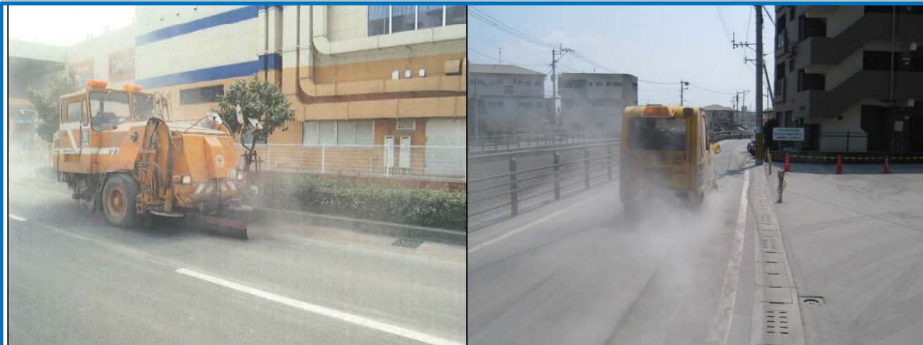
大型清掃車(左)、小型清掃車(右)による道路の清掃状況(H21.4.10撮影)
