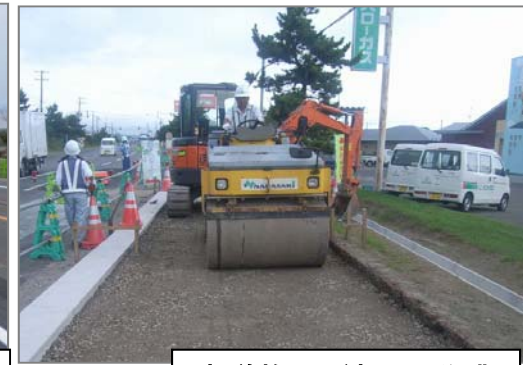
歩道施工：締固め作業
