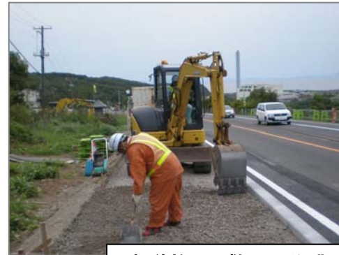
歩道施工：敷均し作業
